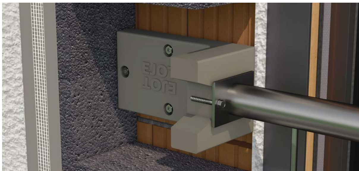
Монтаж крепления ограждения с помощью ISO-Corner .
