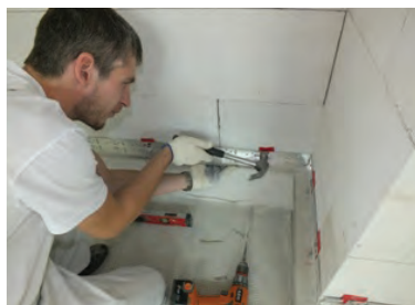
Установка цокольного профиля
