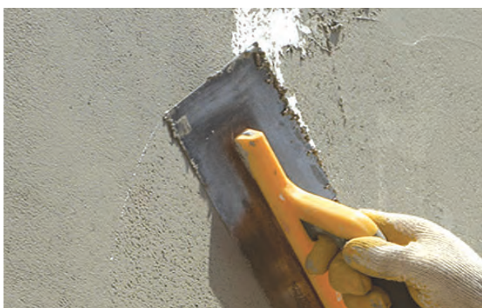
Нанесение базового армирующего слоя
