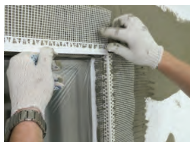
Установка фасадных профилей
