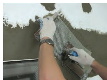
Выполнение дополнительного армирования
