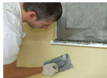
Устройство защитно-декоративного слоя
