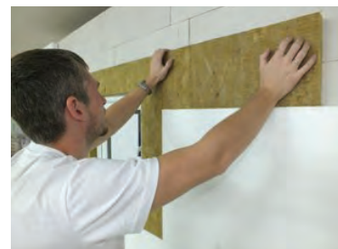
Монтаж противопожарных элементов
