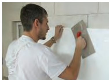
Установка теплоизоляционных плит
