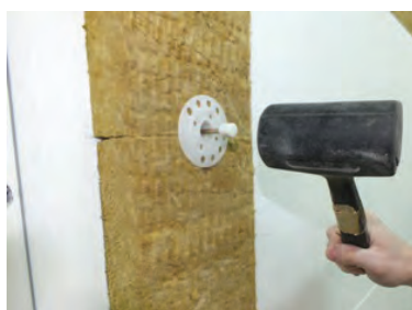
Механическое закрепление приклеенного утеплителя
