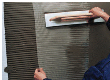
Устройство армирующего базового слоя
