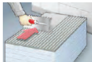
Гребенчатый способ нанесения
